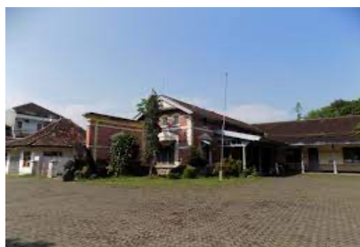
Gambar 3. Kondisi Stasiun Temanggung
