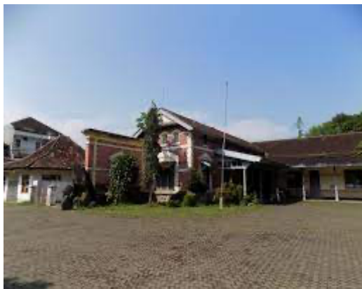
Gambar 1. Kondisi Stasiun Temanggung
